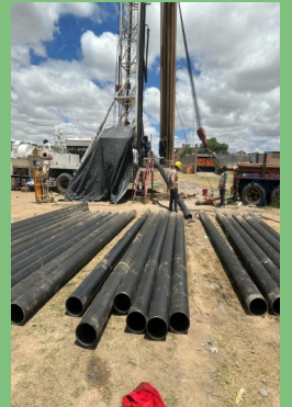
CONTINÚA LA PERFORACIÓN E INSTALACIÓN DE TUBERÍA EN EL POZO DE LA COMUNIDAD DE BIMBALETES
